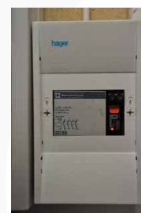
Kontaktor med manöverrelä inbyggd i extern kapsling
