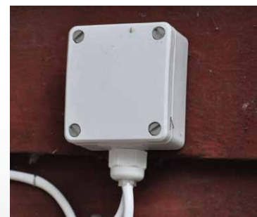
Utomhusgivare, givaren är kopplad i serie med en av inomhusgivarna, därav dubbla kablar
